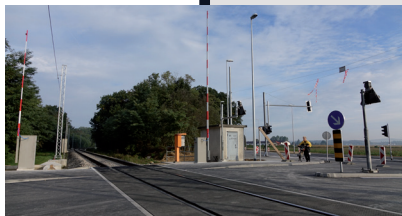
Nov nivojski prehod z urejenim višinskim profilom – omejevalcem višine.
