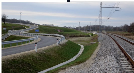
Nova, elektrificirana železniška proga in na novo urejena povezovalna pot čez Pavlovski potok
