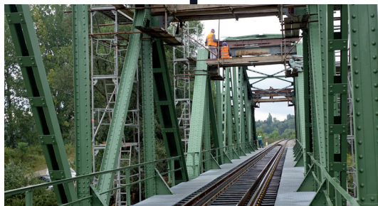
Med obnovo železne konstrukcije mostu
