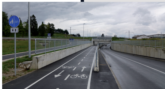
Na novo urejen podhod in cestna infrastruktura.
