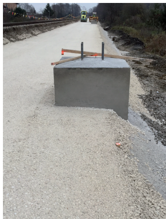
Vgradnja 70-centimetrskega tampona
